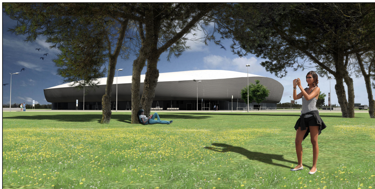
A jégcsarnok főhomlokzata - a feltáró közút irányából
